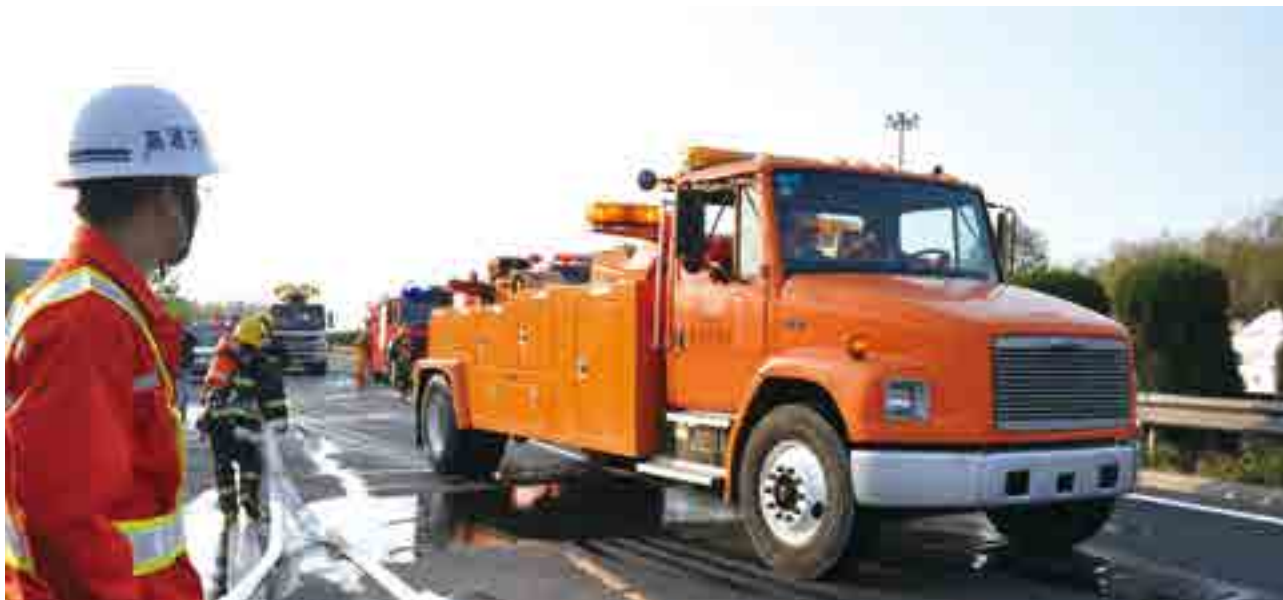
高速公路清排障现场
