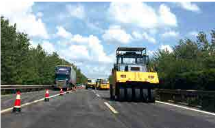
高速公路养护
