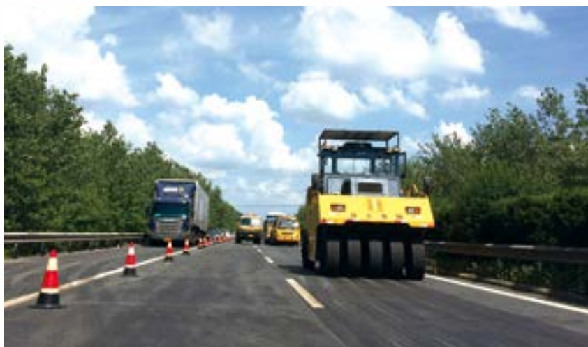
高速公路养护
