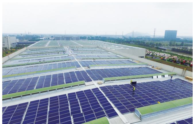
装潮导致组件供应紧张等不利条件,历时约80天,于8月12日下午一次性并网发电成功。项目建设期间,为消除徐工汽车对屋顶电站漏雨等方面的技术顾虑,云杉清能组织技术力量,针对性地优化防水处理,并突破常规采用北坡抬升角度组件布置,提高发电效率,为今后同类项目的设计、建设管理做出了有益积累。
